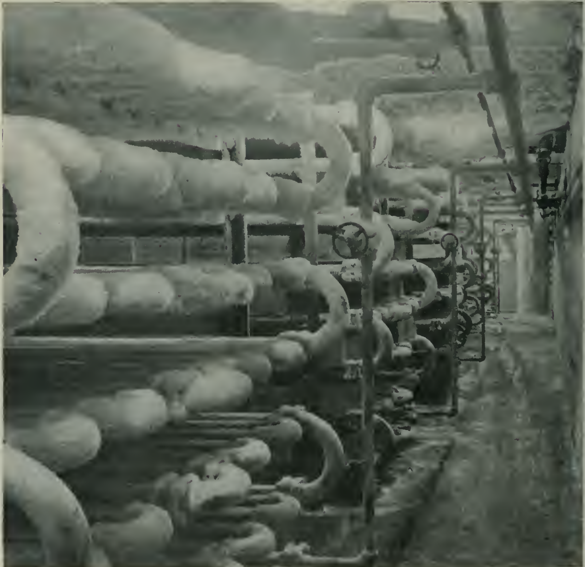
Interior of a Freezing Room in a Fishery Cold Storage. Intérieur de la glacière pour garder les poissons. Interior de una cámara refrigeradora de pescado.
