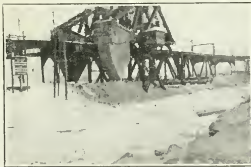
Fig. 4. Kaministikwia River Swing Bridge.
