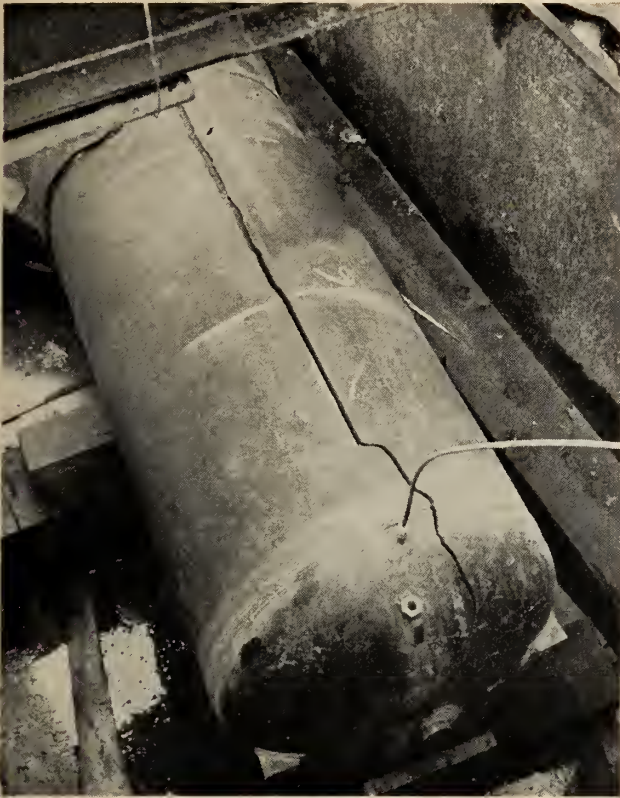
Fig. 15. Burst tested pipe E-1.
