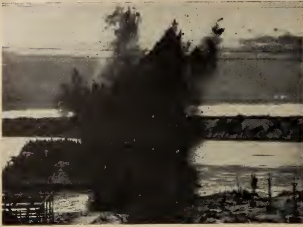
Fig. 25. Tailrace plug blast.
