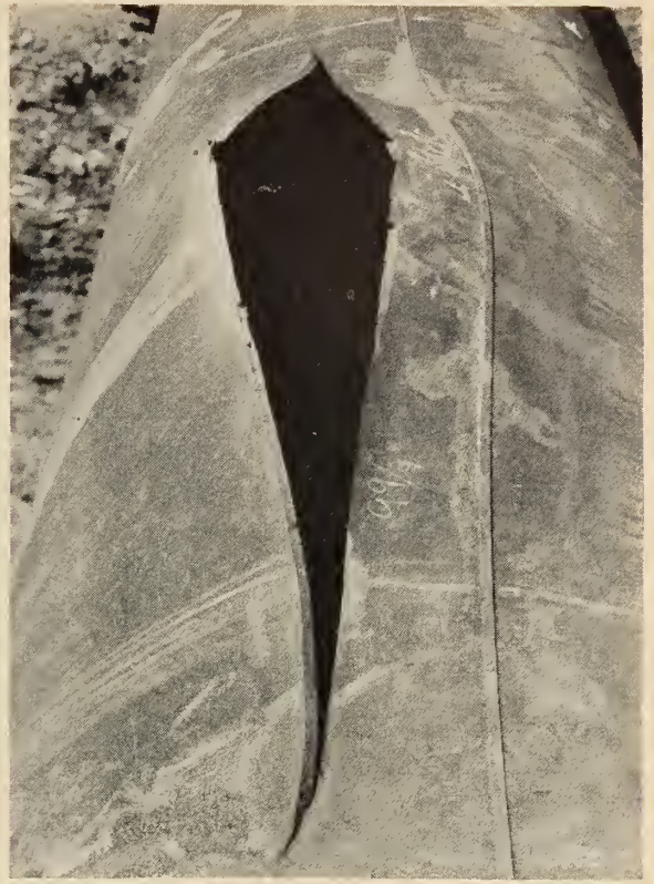
Fig. 16. Burst tested pipe F-1.
