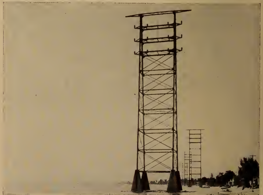
Fig. 2. T. N. P. Co. Towers, Burlington Beach.
